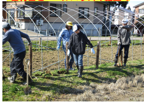
苗育苗ビニールハウスの組立て
